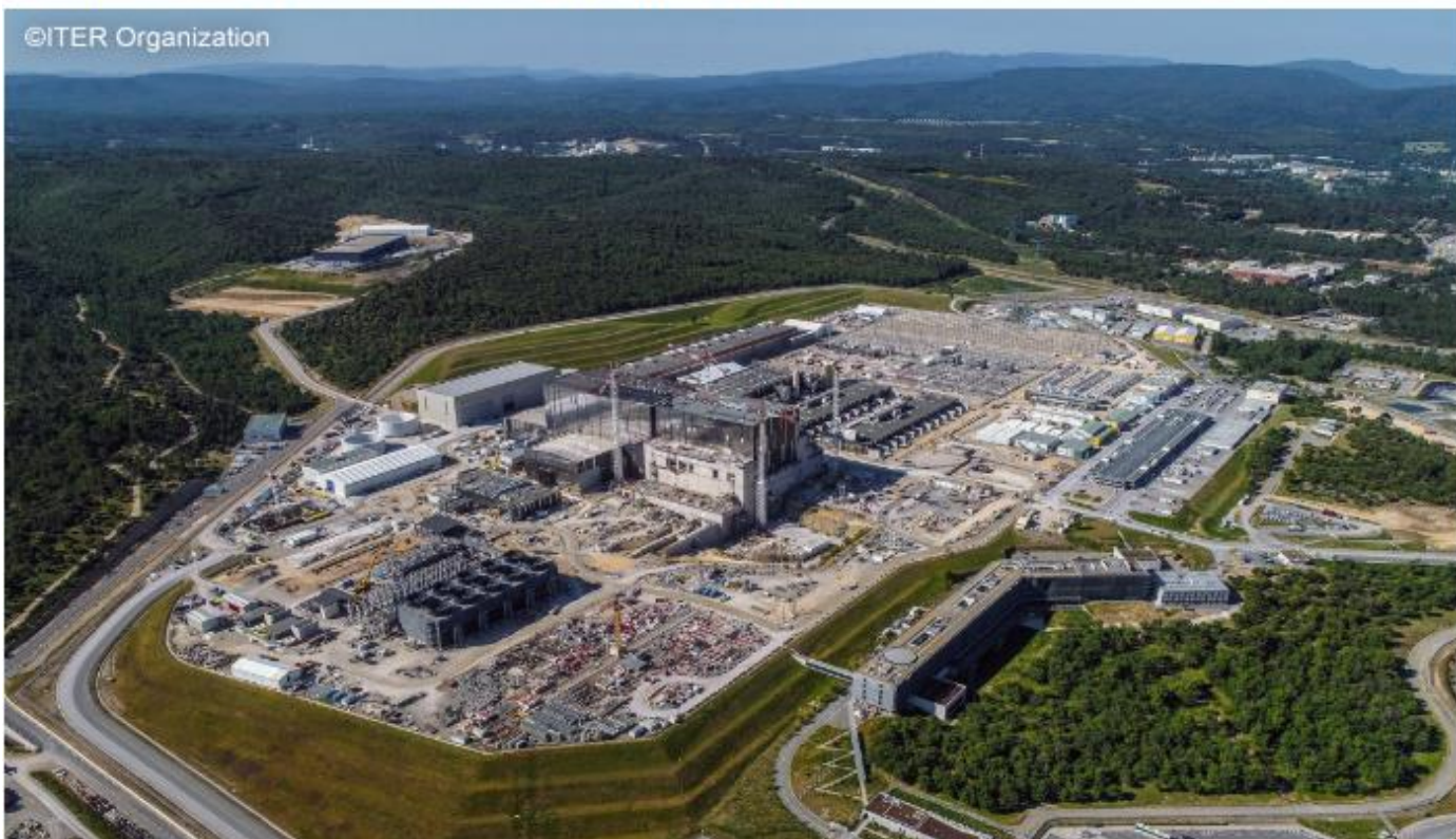
ITER建設サイト全景（撮影：2020年5月）
